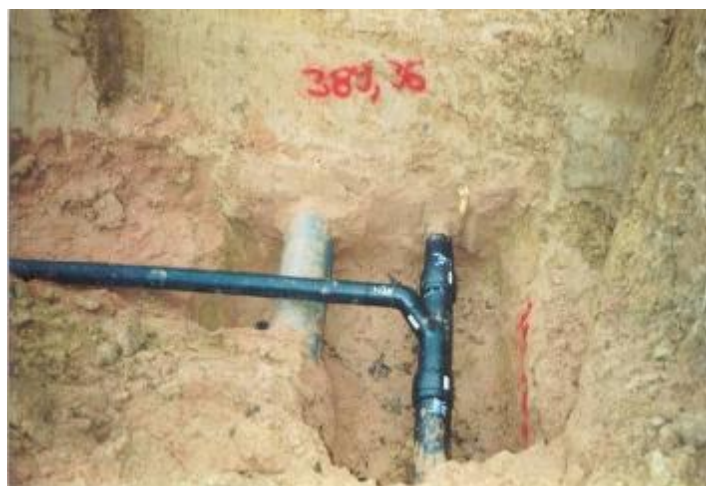
Σχήμα 4: Φωτογραφία ολοκληρωμένης σύνδεσης service line εκ δεξιών
