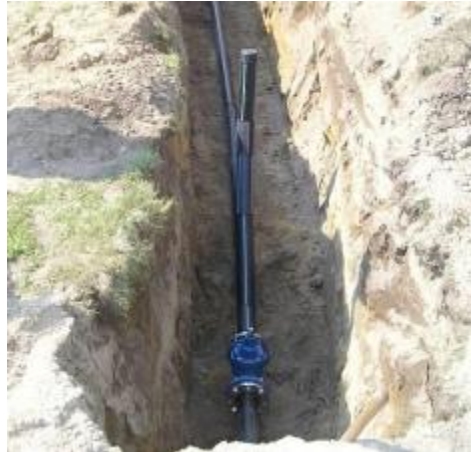
Σχήμα 5: Αγωγός επιθεώρησης HDPE και δικλείδα απομόνωσης πριν την επαναπλήρωση του ορύγματος
