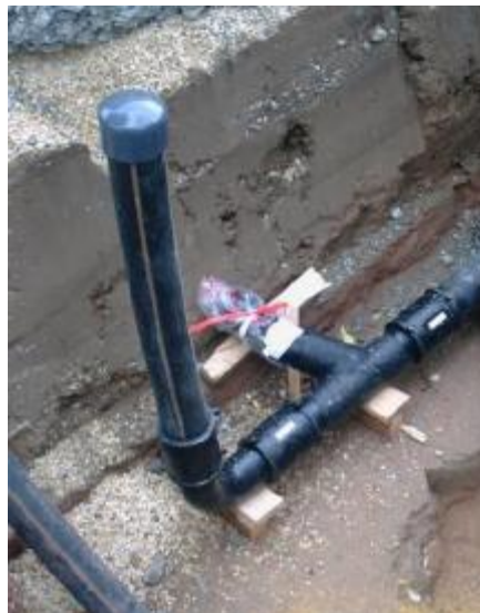
Σχήμα 6: Αγωγός επιθεώρησης HDPE στην αρχή αγωγού
